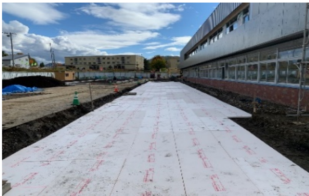
（施工中の様子）
