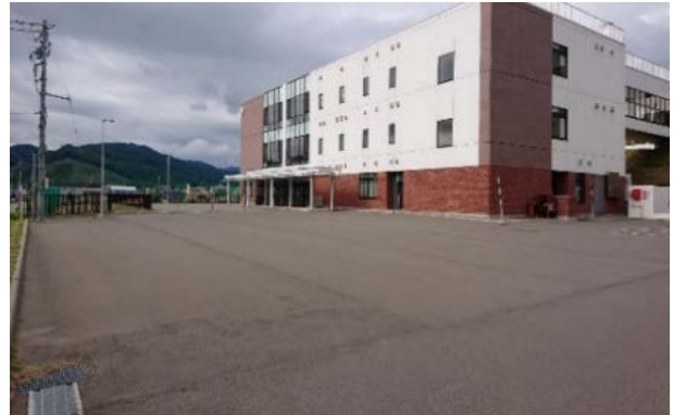
（施工後の様子）
