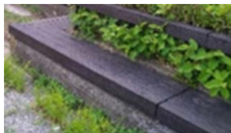
(施工後の様子)
