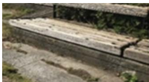
(施工前の様子)
