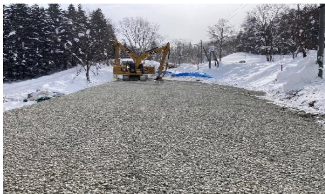
(施工中の様子)
