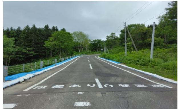
(施工後の様子)
